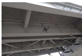
ドローンによる桁下の点検
